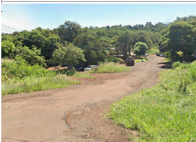
Rua Rio Branco (entre Av. 24 de Outubro e Av. 24 de Outubro + 90 m)
