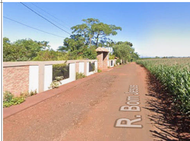
Rua Bom Jesus (entre Av. 24 de Outubro e Rua Santo Cristo + 260 m)
